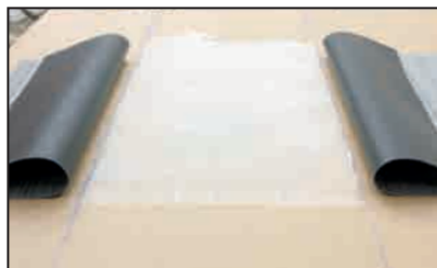
Рисунок 5 - Как начать укладку рулонов
